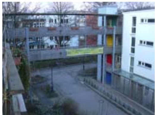
Laubengangbrücken und Aufzug
