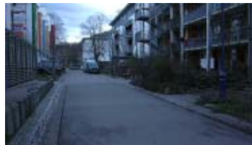
Seitlich an der Straße liegenden Pflasterrinnen zur Aufnahme des Regenwasser
