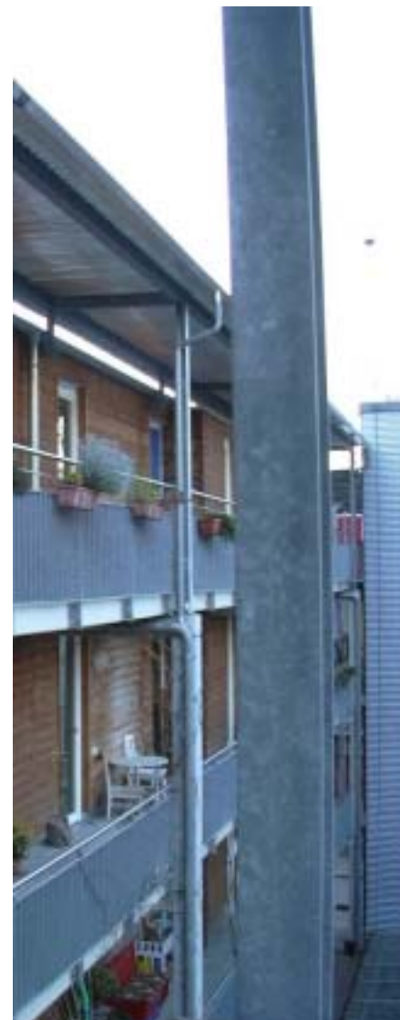
Die Rohre, die zu den Regenwasserzisternen führen, oder das Wasser zu den Pflastersteinmulden führen.
