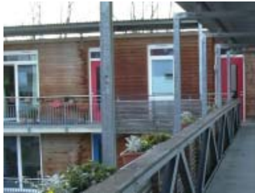
Das feuchte Holz der Fassaden
