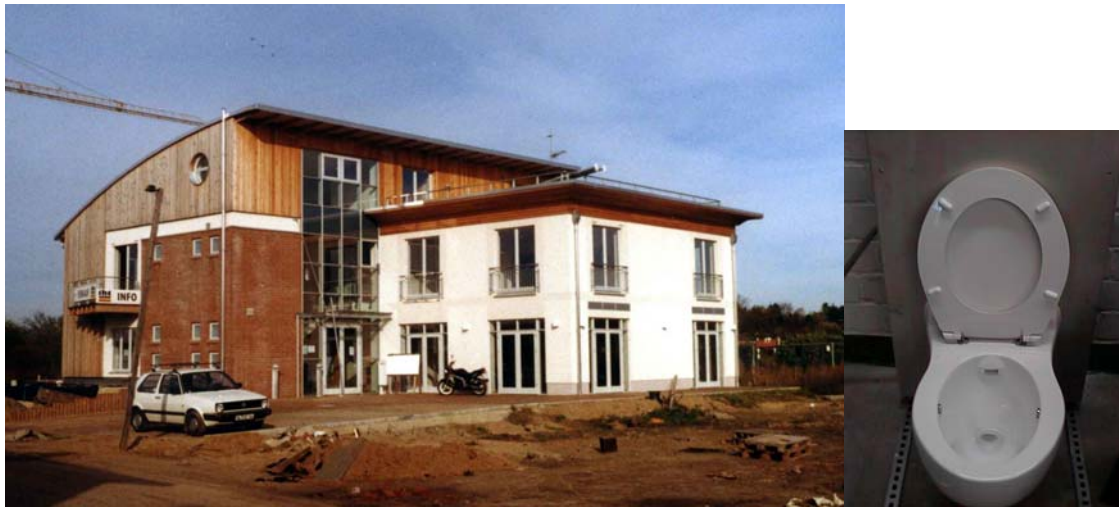
Abb. 2: Gemeinschaftshaus der Siedlung Flintenbreite in Lübeck, Detailbild Vakuumtoilette (Spülwasserverbrauch ca. 0,7 l)
